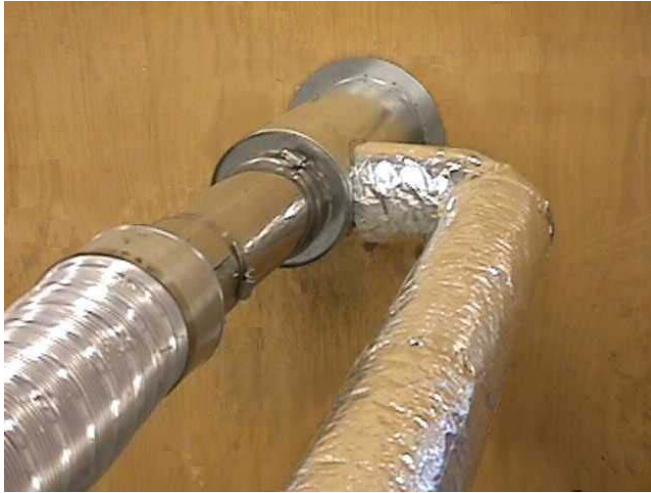
VUE INTÉRIEURE DE LA TERMINAISON DU TUYAU
